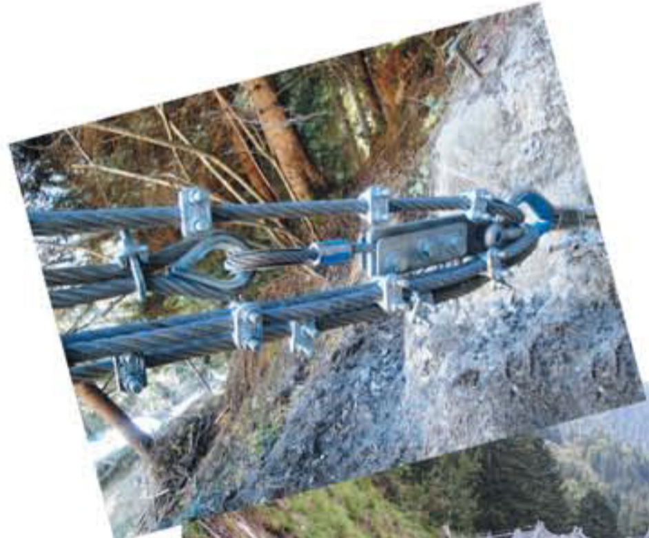
Opera di consolidamento di versanti franosi mediante la posa in opera di reti armate e pannelli in fune a protezione Skiweg Prafiori in loc. Alpe Cermis (Committente Funivie Cermis SPA)
