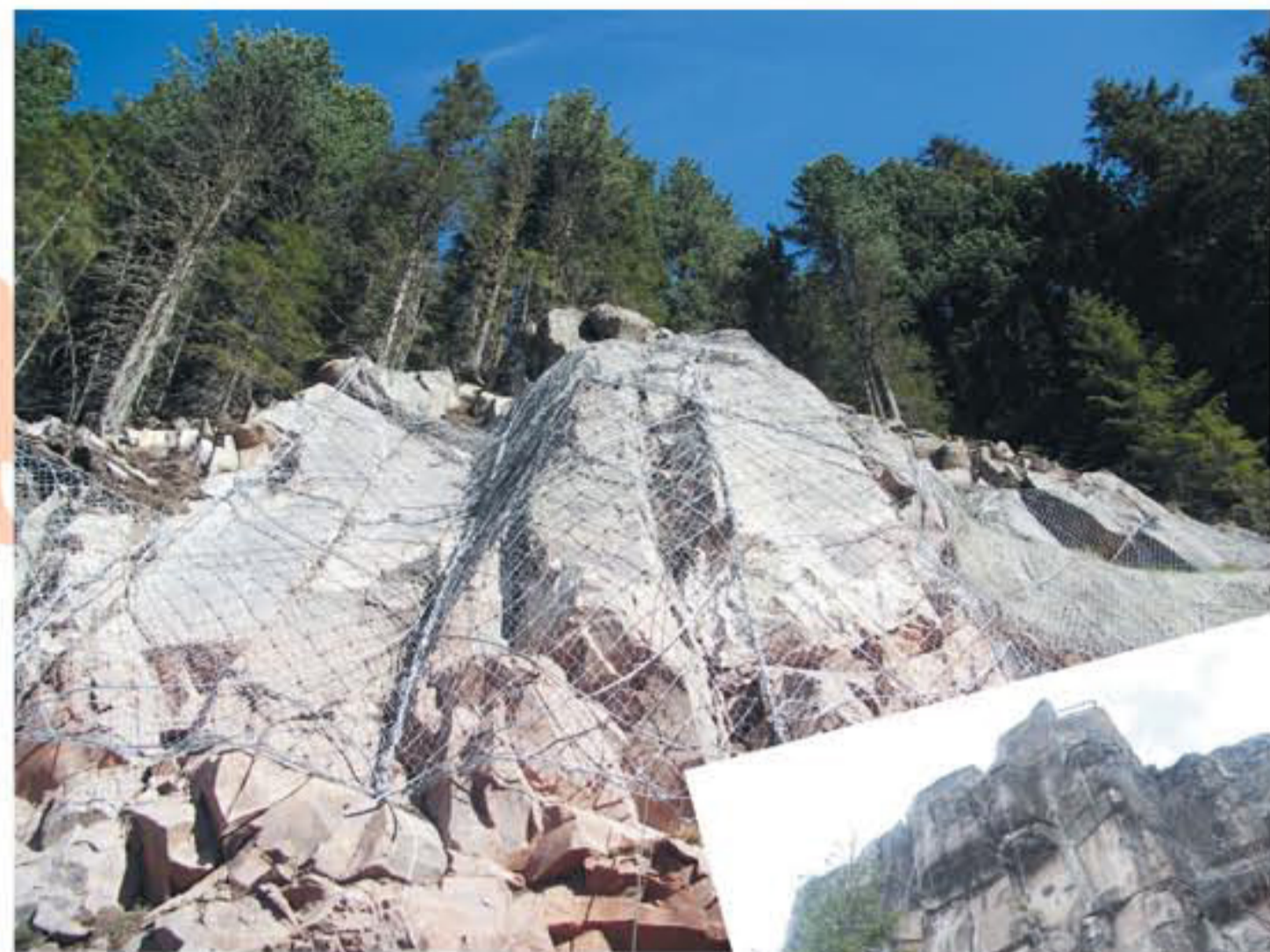
Opera di consolidamento di versanti franosi mediante la posa in opera di reti armate e pannelli in fune a protezione Skiweg Prafiori in loc. Alpe Cermis (Committente Funivie Cermis SPA)
