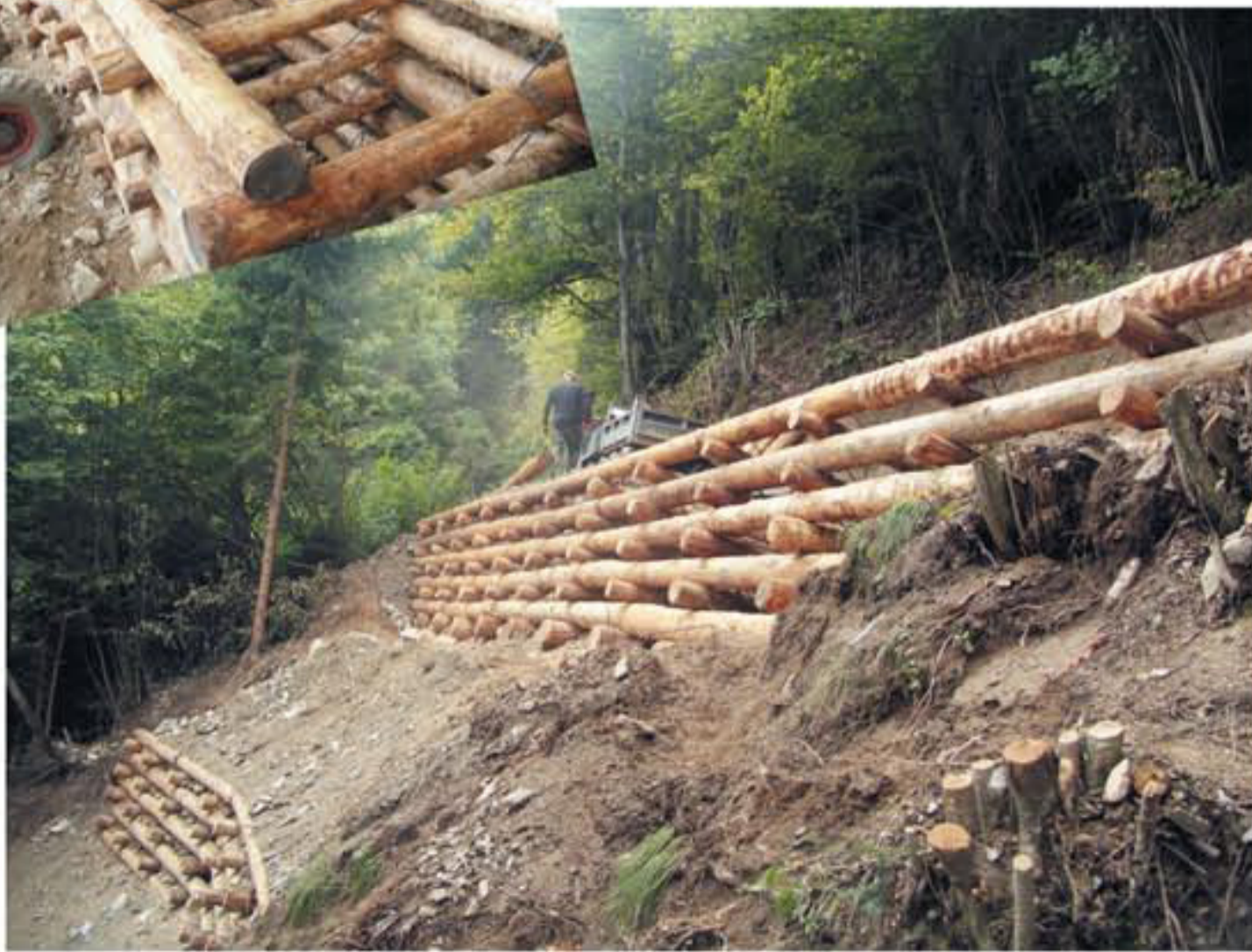
Lavori di "somma urgenza per sistemazione dei dissesti lungo la Via Nova in C.C. Mezzano" (Committente Comune di Mezzano - TN)
