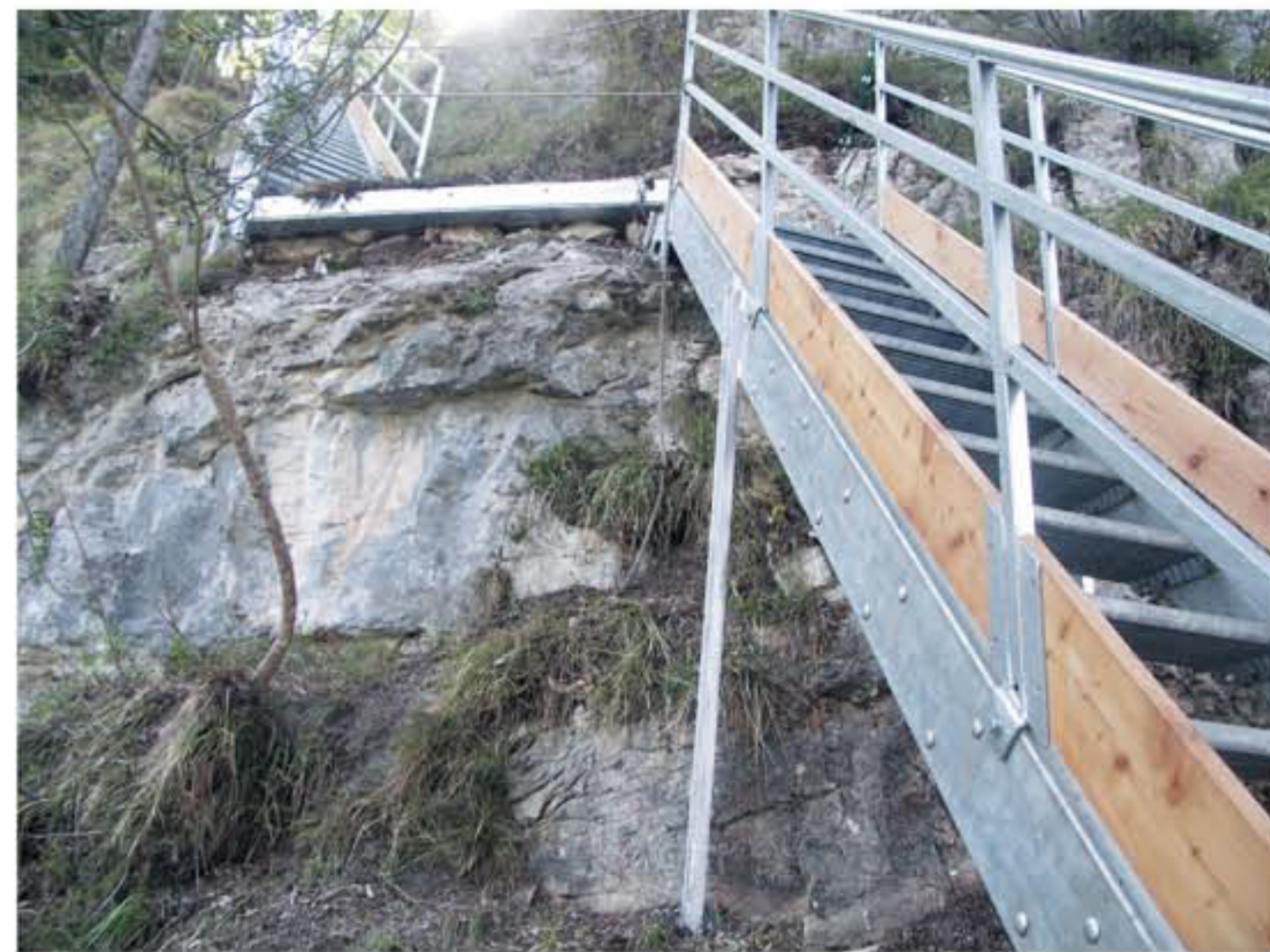
Lavori di messa in sicurezza sentiero di servizio centrale idroelettrica di San Silvestro Imèr - TN (Committente Primiero Energia SPA)
