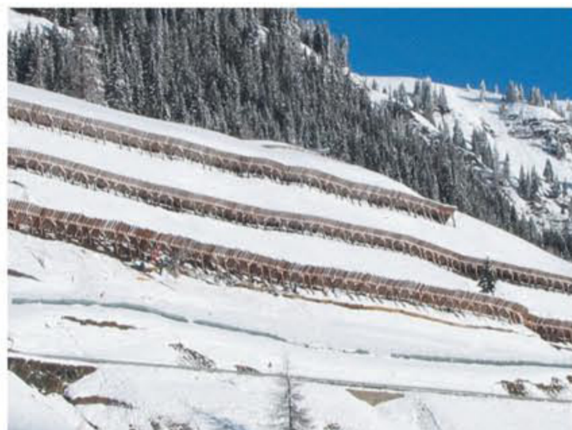
"S.P. 244 "Della Val Badia" Lavori di protezione del piano viabile da caduta valanghe sito in Playaz dal Km 40+000 al Km 40+250. I° e II° Stralcio (Committente Veneto Strade SPA)
